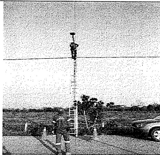
Instalacion de luminarias
