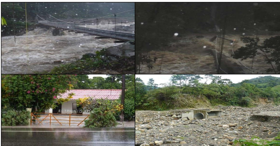
Arriba: Creciente del 30 de Mayo de 2008 en el caño Aguas Claras, antes y después de la caída del puente veredal cercano a la construcción de la Bocatoma del Acueducto regional del Ariari Fte.: Edesa S.A. E.S.P. Abajo: A la izquierda Inundación paralela a la vía a San Martín, ocasionada por el Río Guamal; A la derecha, estado final del Box coulvert sobre el caño Perro Loco luego de la gran avalancha. Fte.: Izq. Cruz Roja Colombiana, Der. Contraloría Meta
