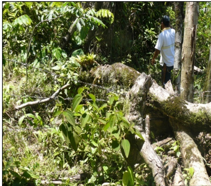
Cercado perimetral caído Fuente: Contraloría Departamental del Meta
