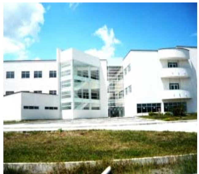
Foto1. Fachada Hospital Departamental de Granada
